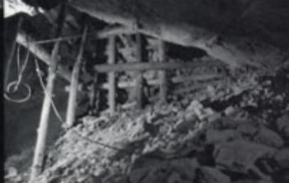
下方より掘り進めて行ったので、やぐらを立て上へ向けて探掘している。
